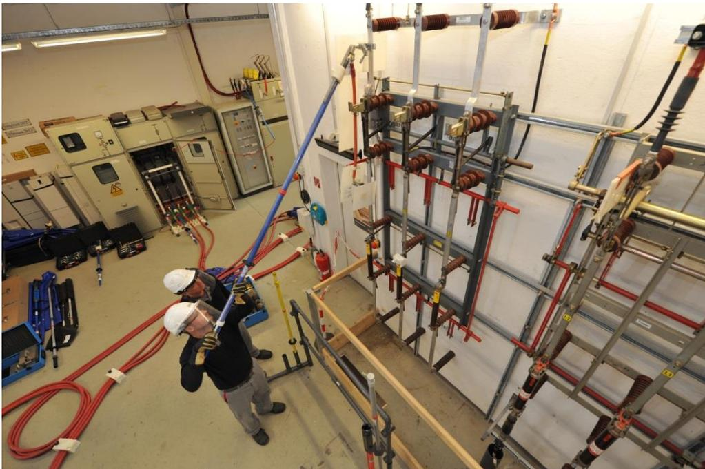
Einbau und Anschluss einer Überbrückungsleitung, des einphasigen Überbrückungssystems an einem Schaltgerät in Netzstationen mit turmartiger Bauform
